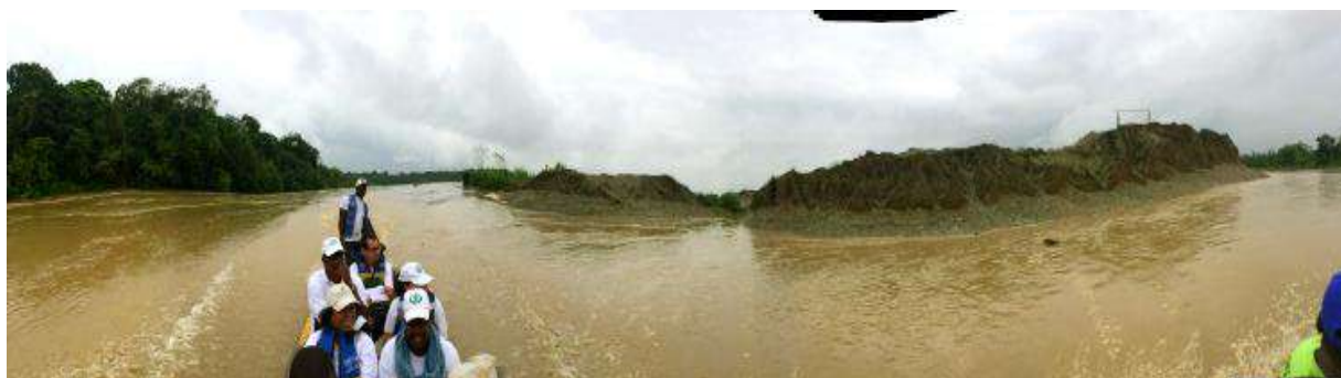
Fotografía 54: Destrucción del cauce del río Quito
