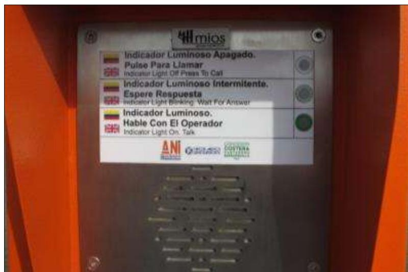
**Figura N°15.39 Teléfono SOS en viaducto con alimentación eléctrica solar**
