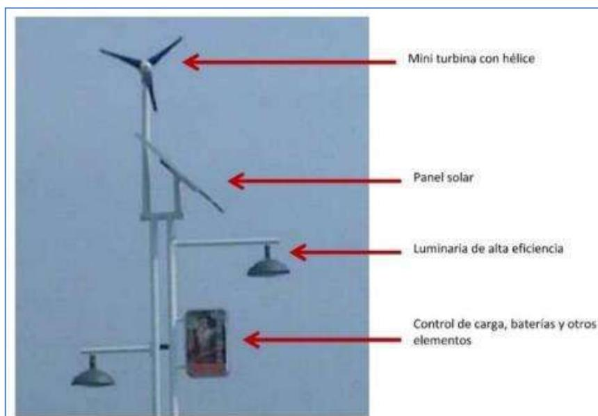
La fotovoltaica (energía solar) y la energía eólica solo alimentan el sistema, mientras el banco de baterías o sistema de acumulación de energía recibe o entrega energía dependiendo del equilibrio de suministro y demanda eléctrica.
